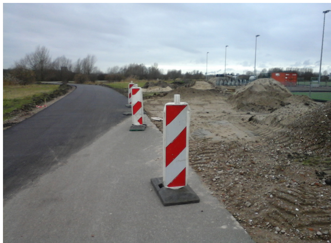
Verlegging van het Jan Beijerpad in 2016
