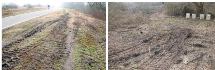
Berm Diemerzeedijk naast de ARK-zone (03-03-2021)
