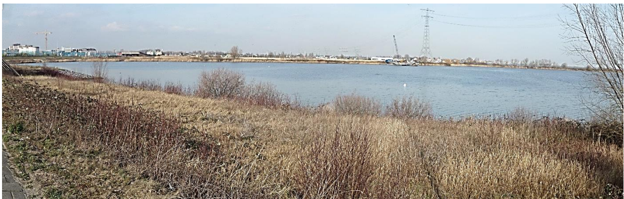
Blik op de Oostpunt vanaf de IJburglaan langs de A10 met de te dempen baai op de voorgrond voor het sportterrein op locatie 2. Tussen de A10 en het sportterrein kan een fietspad worden aangelegd naar de Zuider-IJdijk.
